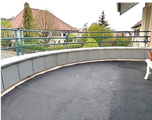
Etanchéité avant la pose des lames composites
