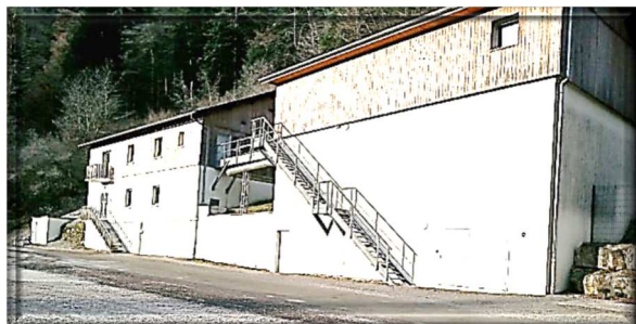
Centre de traitement de l'eau à Blanchefontaine
